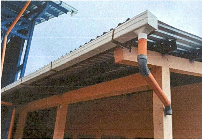
Foto1: Mejoramiento de techado de aula con instalcion de lamina troquelada calibre 26.
