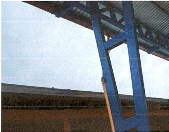
Foto 3: Instalación de canales pluviales
