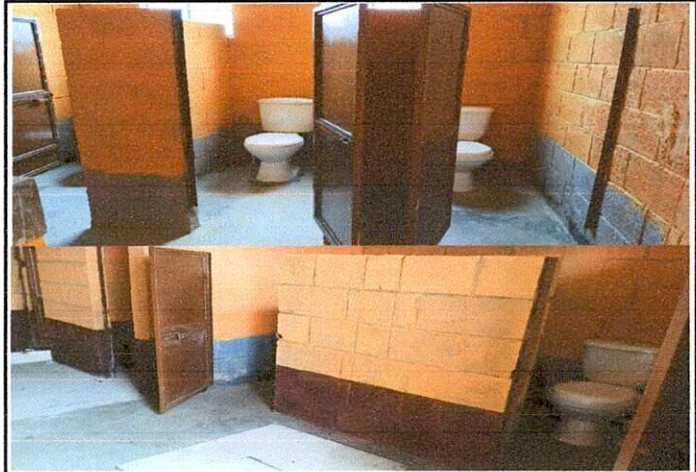
Foto 2: Mejoramiento de servicios sanitarios
